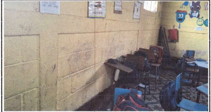
Foto 8: Pintura en muros interiores.
