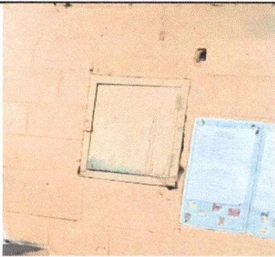
Foto 3: Sustitución de ventanas de madera por metal mas vidrio.
