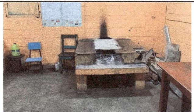
Foto 16: Sustrucción de estufa rural (completa) incluye chimenea y plancha de metal. Instalación de azulejo en estufa rural.
