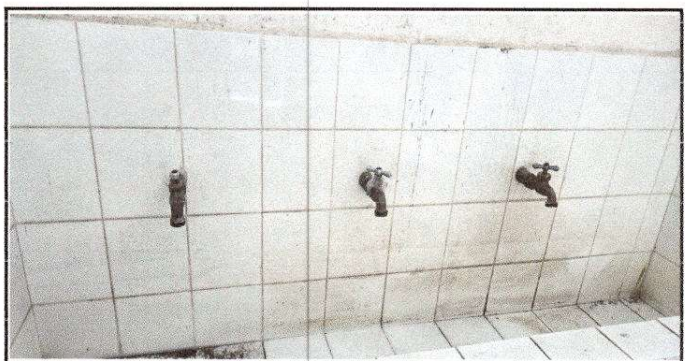
Foto 12: Sustitución de llave de chorro.
