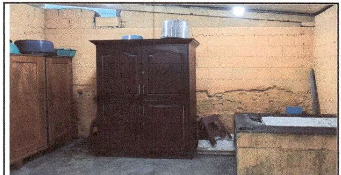
Foto 18: Repello en muro.
