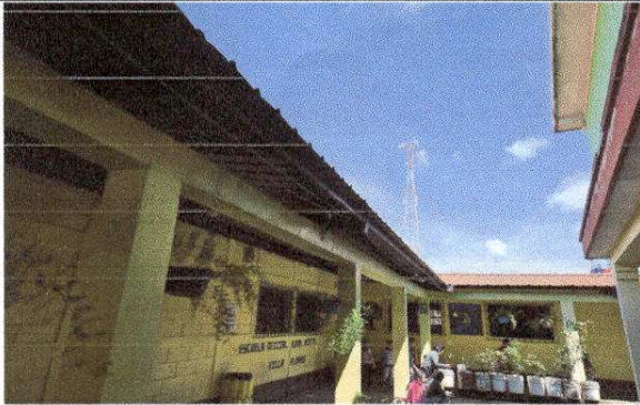
Foto7: Sustitución de canales de PVC y bajada de agua pluvial.
