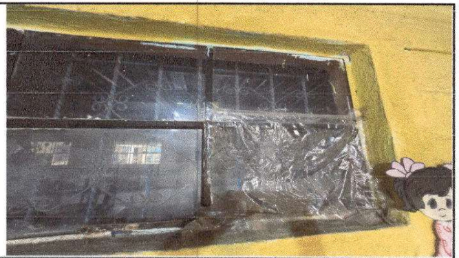
Foto 4: Sustitución de vidrios.
