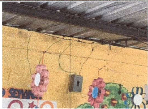
Foto 14: Sustrucción de tablero de flipones.
