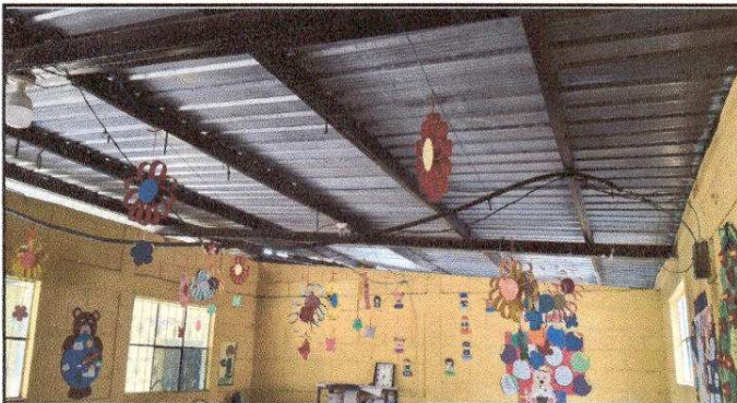
Foto 15: Reparación de cableado electrico
