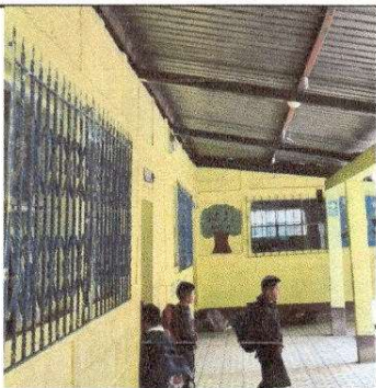
Foto 5: Mantenimiento a balcones de metal.
